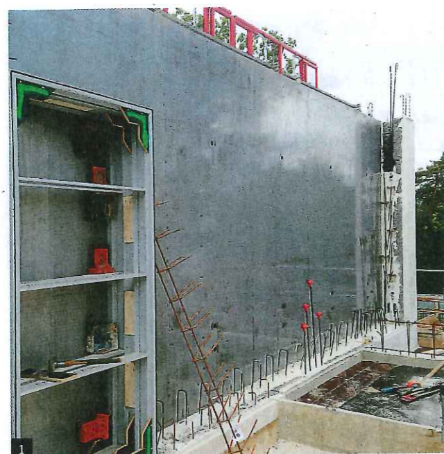
1 - Les banches côté intérieur, correspondant au voile porteur, sont posées en premier, avant les mannequins de baies et autres réservations. 2 - Les armatures du mur porteur sont posées contre la banche, avec leurs écarteurs, comme pour un voile classique.
