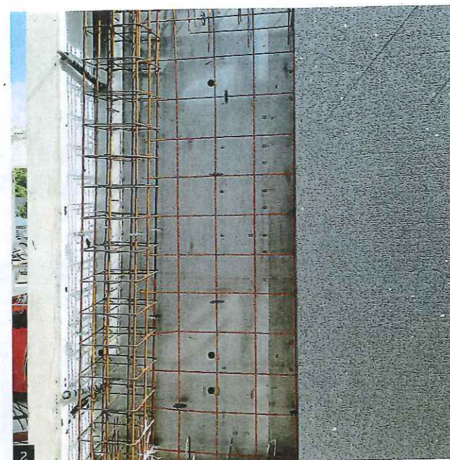
1 - Les banches côté intérieur, correspondant au voile porteur, sont posées en premier, avant les mannequins de baies et autres réservations. 2 - Les armatures du mur porteur sont posées contre la banche, avec leurs écarteurs, comme pour un voile classique.
